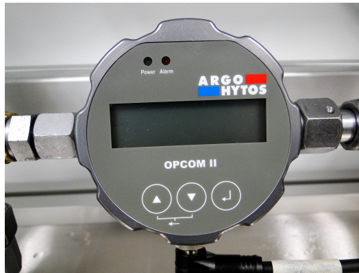
Rysunek 7.7: Czujnik do pomiarów klasy czystości oleju
