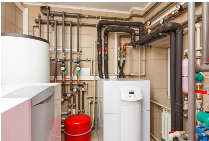
Rysunek 1.6: Kotłownia w domu z pompą ciepła
