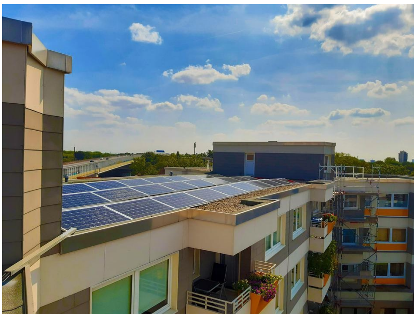
Rysunek 1.1: Panele fotowoltaiczne na budynkach mieszkalnych
