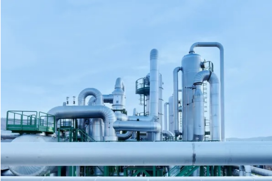
Rysunek 1.5: Instalacja ciepłowni geotermalnej
