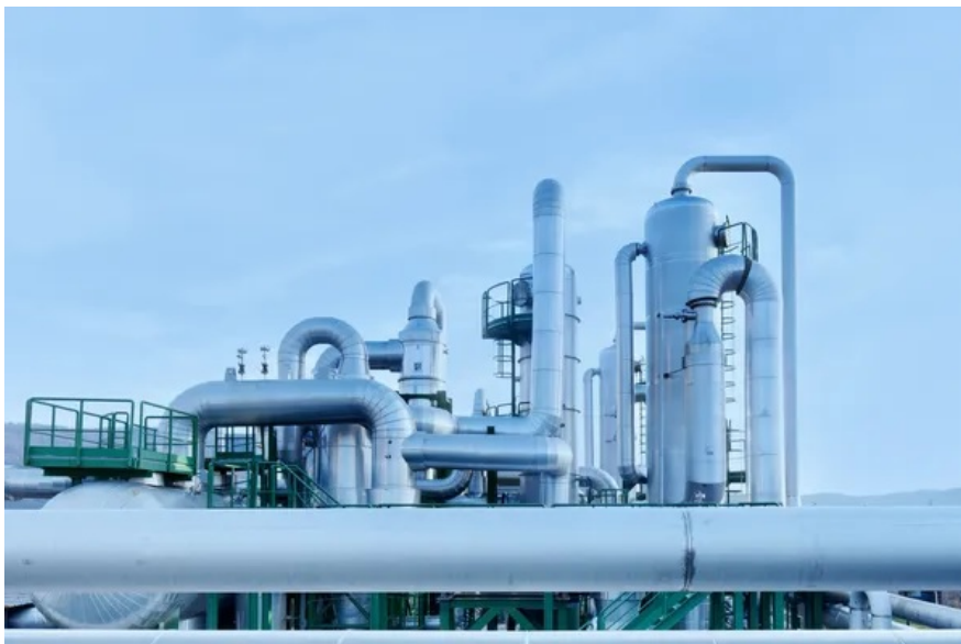
Rysunek 1.5: Instalacja ciepłowni geotermalnej
