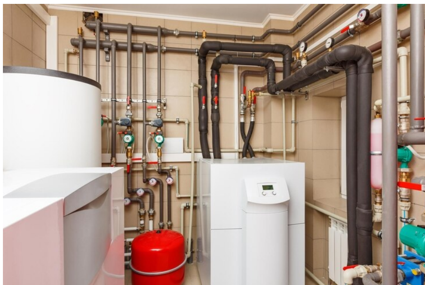
Rysunek 1.6: Kotłownia w domu z pompą ciepła
