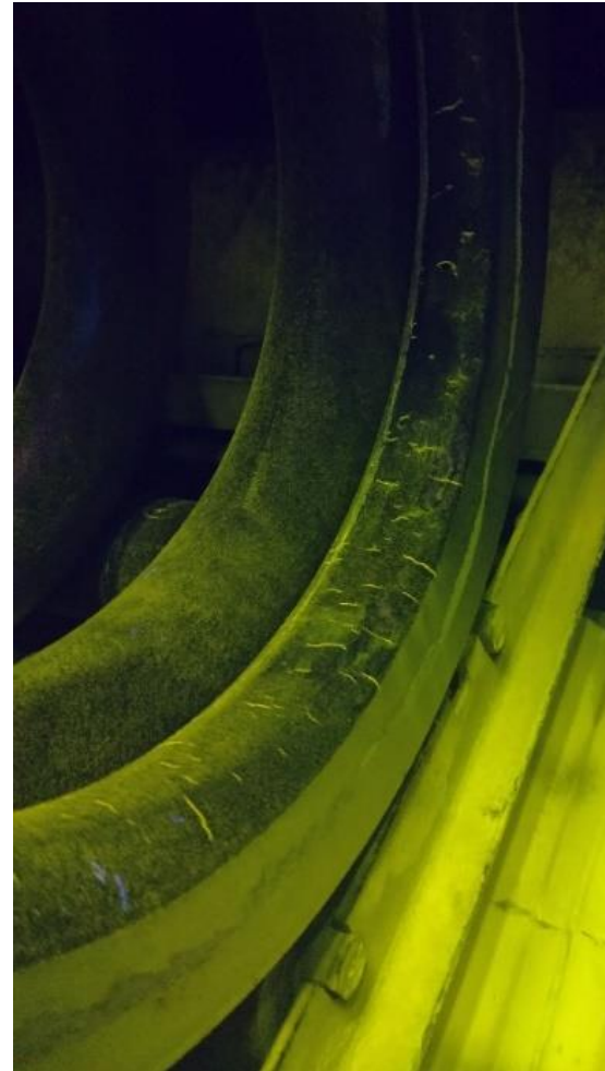
Rys. 6. Przykład nieciągłości poprzecznej na 1 zwoju sprężyny
