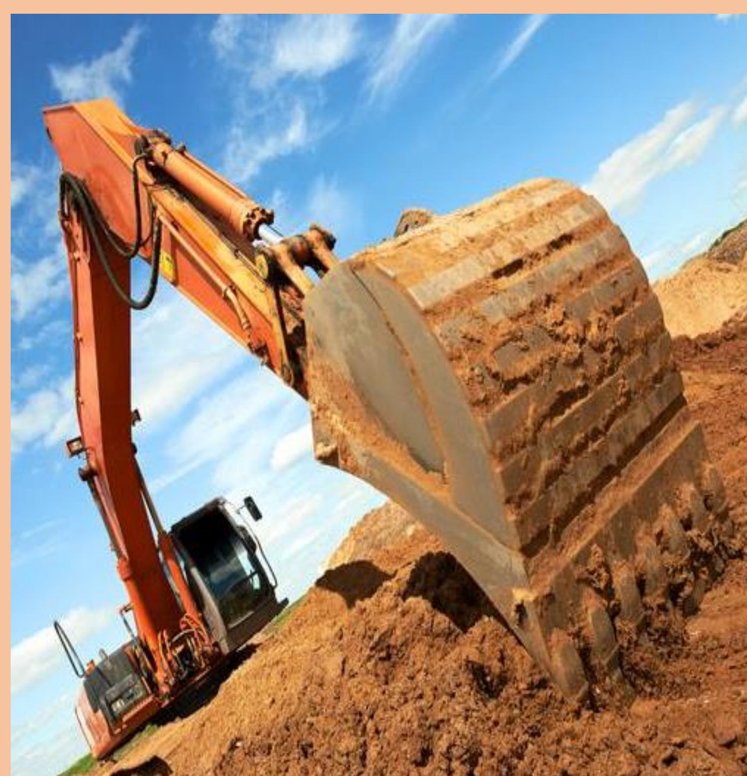
Rys. 2 Koparka podsiębierna z elementami roboczymi
